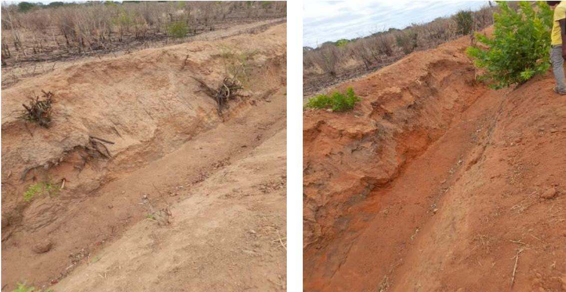
**Figura 2 – Paredes da trincheira sofrendo de erosão**
