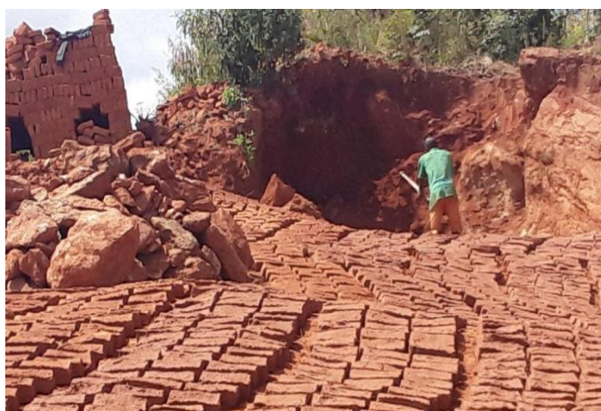
Figura 9 – Extração de argila pelos moradores. Fonte: Autores (2022).
