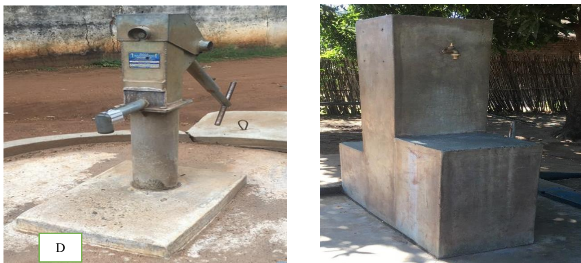
Figura 6 e 7 – Furos mecânicos e fontanário usado para ter acesso à água pela população de Bohola
